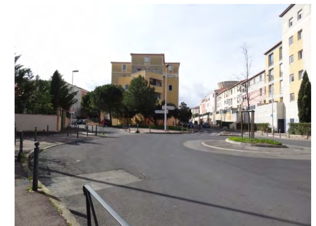
Logements collectifs avenue de Rome et rue Jean Cavallès
