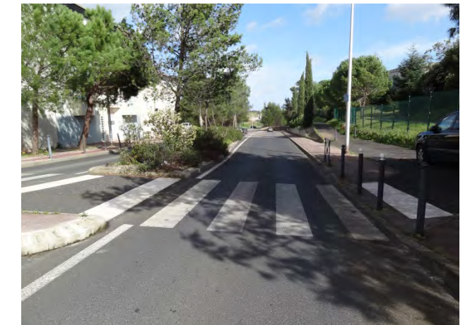
Avenue de Rome au Nord du site
